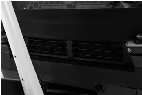
Fig. 40 : Ouvertures d'aération du box
